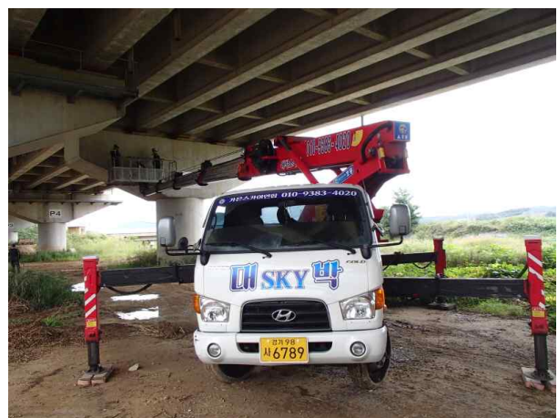
고소점검차를 이용한 조사(S3~S9)
