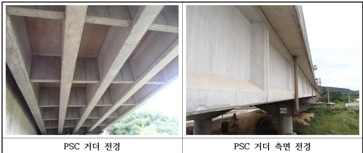
【사진 3.5】 PSC 거더 전경
