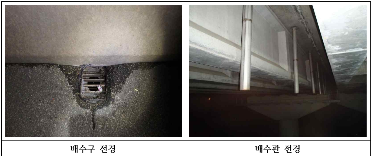
【사진 3.19】 배수시설 전경
