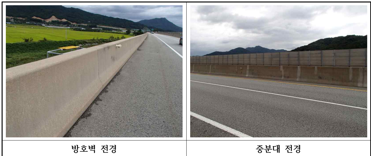
【사진 3.21】 난간 및 연석 전경
