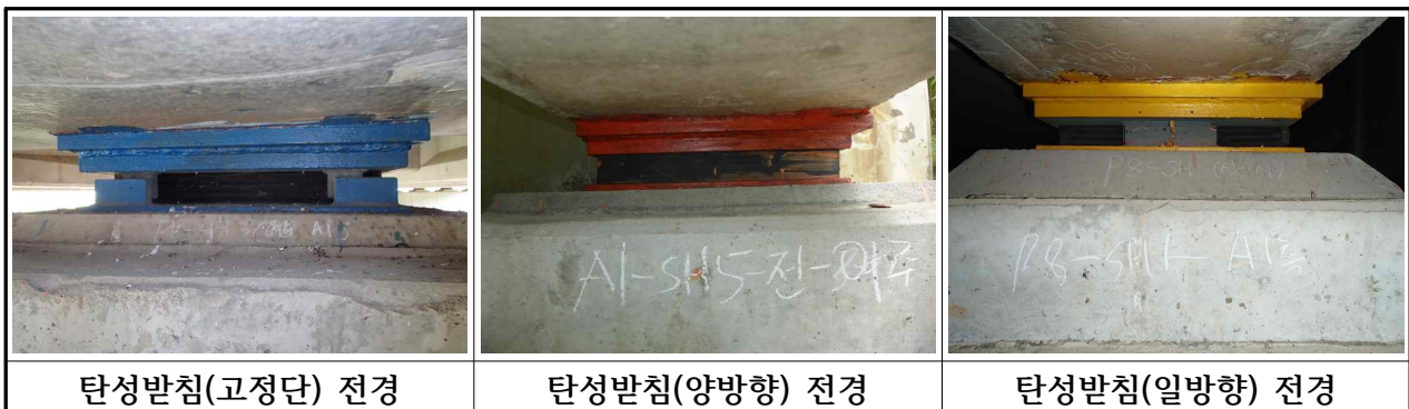
【사진 3.12】 교량받침 전경
