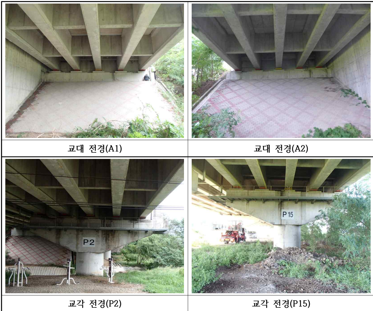
【사진 3.9】 교대 및 교각 전경
