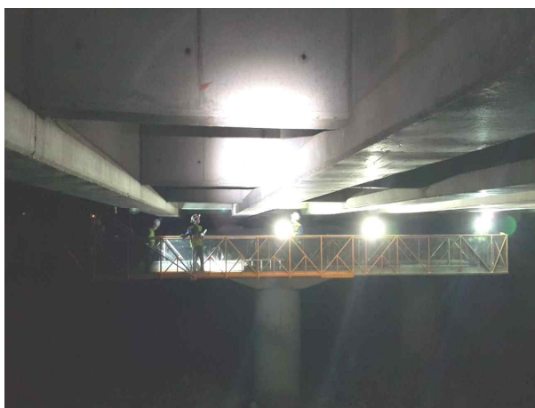
교량점검차를 이용한 조사(S1~S2, S10~S17)
