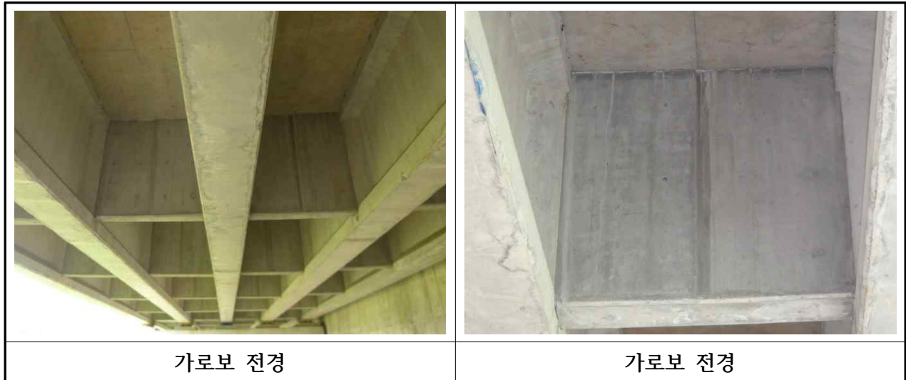
【사진 3.7】 가로보 전경
