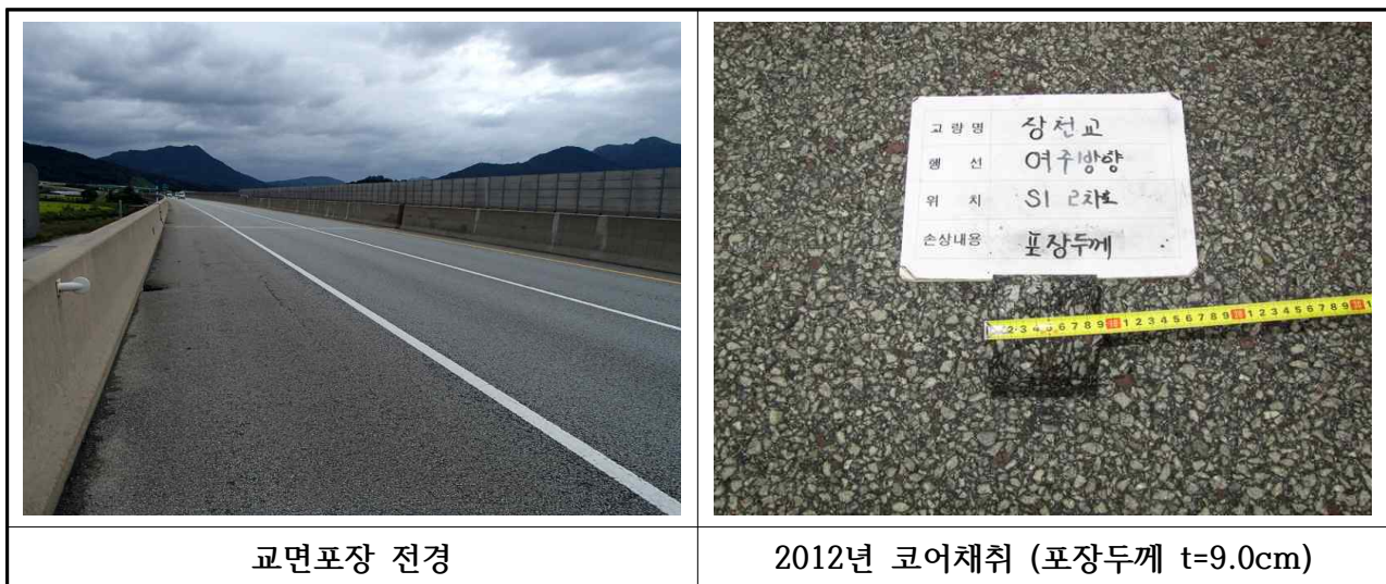
【사진 3.17】 교면포장 전경
