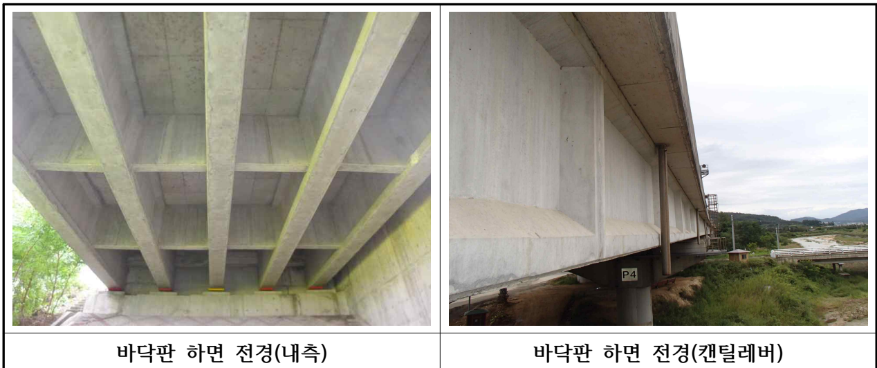
【사진 3.2】 바닥판 전경
